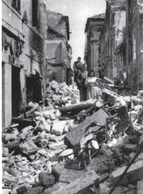
Una via di Zara dopo i devastanti bombardamenti tra il novembre 1943 e l'ottobre 1944
